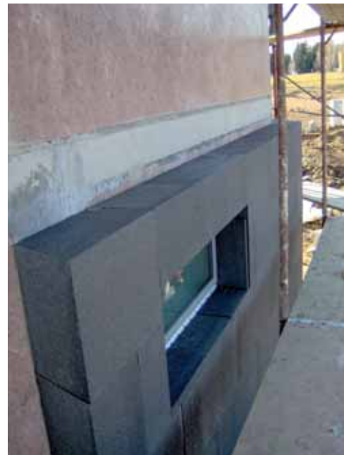
Bild 8: Passivhaus-Wanddämmung
