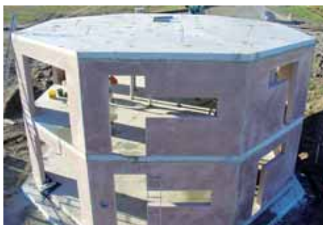
Bild 7: Fertiger Rohbau nach nur 2 Werktagen
