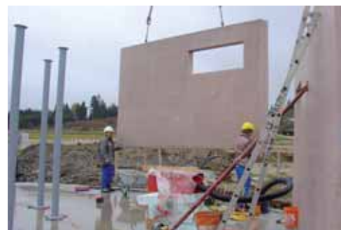
Bild 5: Versetzen der Wandelemente
