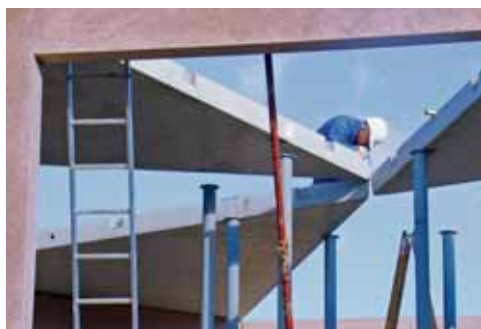
Bild 6: Punktgenaues Zusammenfügen der Deckensegmente
