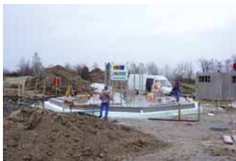
Bild 3: Entstehung Fundamentplatte
