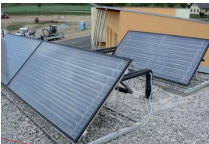
Bild 12: Thermische Solaranlage
