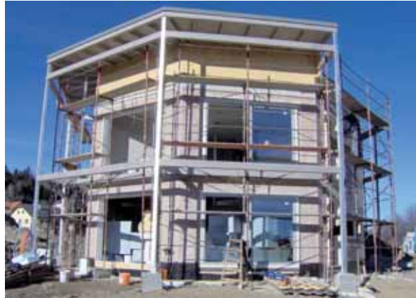
Bild 10: Eingebaute Fenster- und Türelemente
