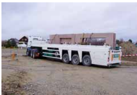
Bild 4: Anlieferung der massiven Fertigteile
