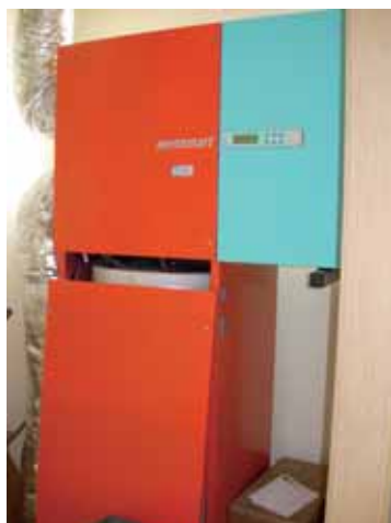
Bild 11: Kontrollierte Wohnraumlüftung mit Wärmerückgewinnung
