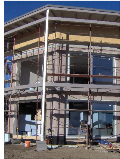
Die Arbeiten am Sonnenplatz laufen auf Hochtouren: Im Mai soll das Musterhaus fertig sein. Foto: z.V.g.
