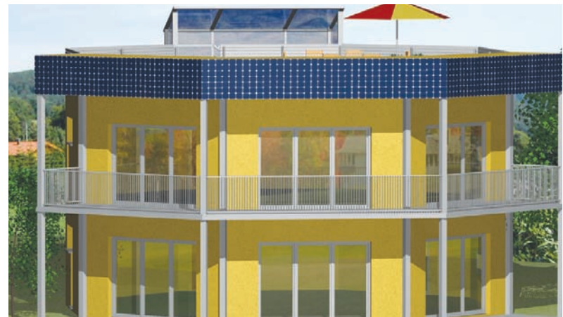
Einladend: So wird das Muster-Passivhaus nach Bauende aussehen. Foto: zVg
